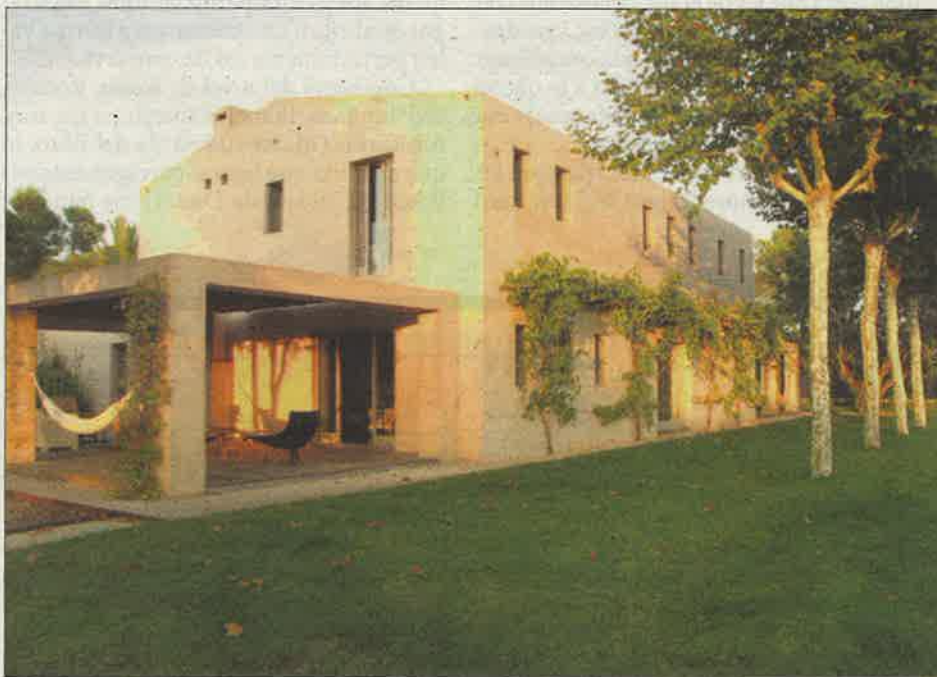
Muros exteriores de adobe y estucado como acabado de la fachada.
