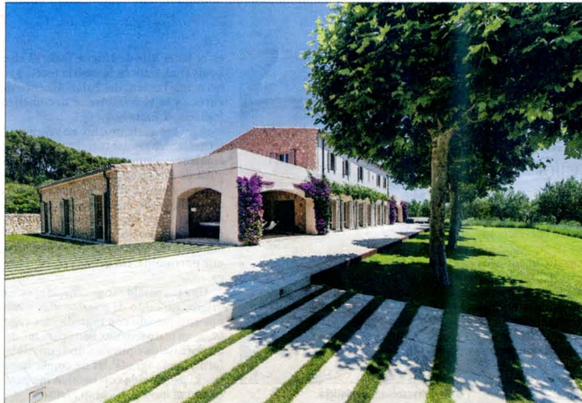
Exterior de la villa. Los árboles de hoja caduca dejan paso al sol y al calor en invierno y protegen en verano.
