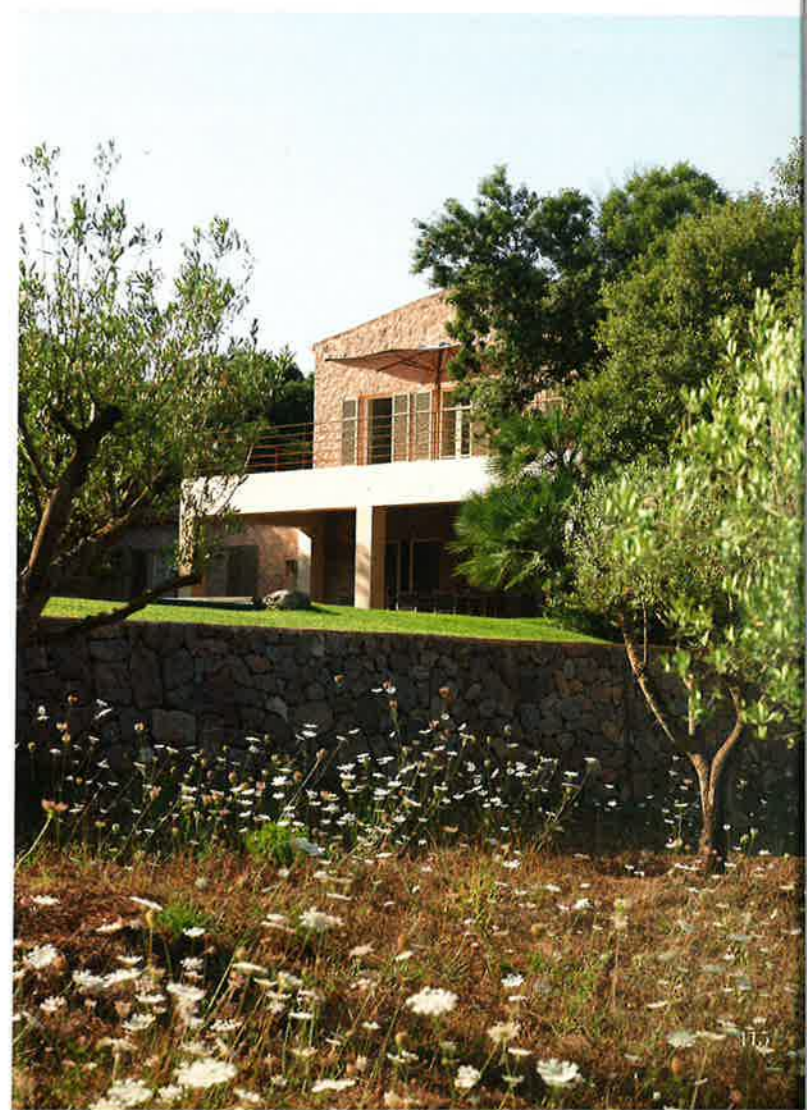
Zaubergarten: Vom Tor des Patio führt zwischen dem Agapanthus ein Weg aus Natursteinplatten zur Haustür. Das leicht abfallende Gelände wird durch eine Terrasse mit Bruchsteinmauerwerk begradigt.
