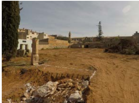
Previous state of the plot and staking out at the start of building work | Estado previo de la parcela y replanteos al comienzo de las obras | Estado previo da parcela e traçados no início das obras
